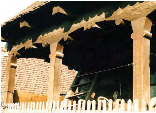
9. Casa. Târnațul casei: a. săgeată; b. șezată; c. „cursură înflorat”; d. grinzană; e. colniță de scară; f. roștei; g. temelia casei; h. treptele de piatră; i. „șută la acoperiș” (pinion); j. lăcrimar protector al ferestrelor; k. talpa casei.
