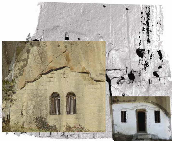
Biserica de la Corbi: restituire digitală realizată după scanare 3D laser și axonomie izometrică.
