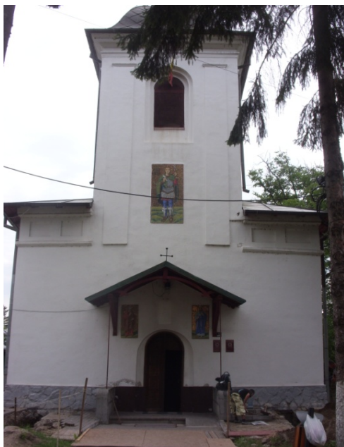
La începerea lucrărilor
